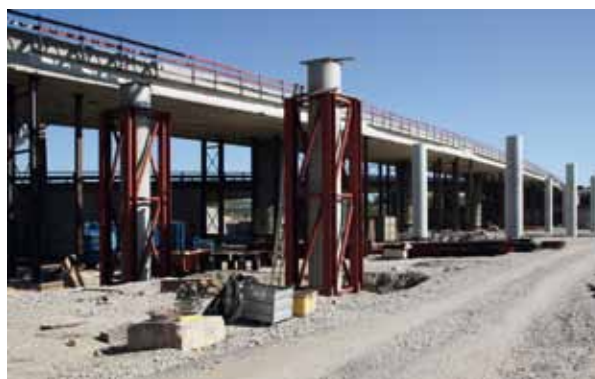
4 Hochbrücke Freimann an der BAB A 9; temporäre Stützen für die Lagermontage © Maurer Söhne GmbH & Co. KG
