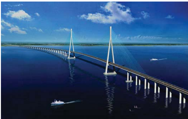
Sutong-Brücke über die Hangzhou Bay in China
