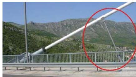
Anordnung der adaptiven Seildämpfer
