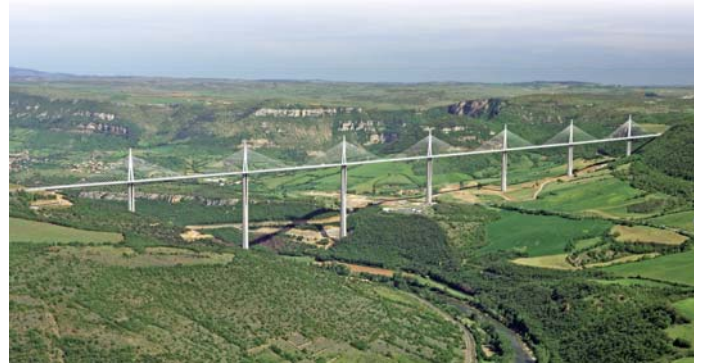
343 Meter: Auf dem höchsten Brückenpfeiler der Welt überquert in Südfrankreich das Viadukt von Millau seit 2004 das Tal des Flusses Tarn. Es ist eines der wenigen jüngeren Brücken-Großprojekte in Europa. Foto: Eiffage CEMV / Foster + Partners / D. Jamme
