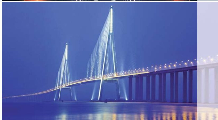
1088 Meter: So weit stehen seit 2008 die zwei 306 Meter hohen Pylone der Sutong-Brücke im Jangtse unweit von Schanghai auseinander. Ihre 272 Seile sind bis zu 541 Meter lang. Fotos: dpa
