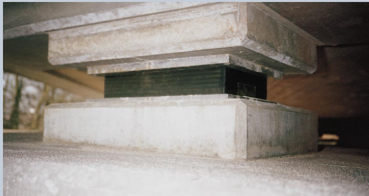
Eingebautes Erdbebenverformungslager
