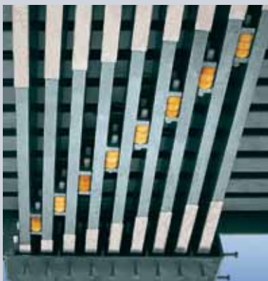
Steuerung von MAURER Trägerrost-Dehnfugen
