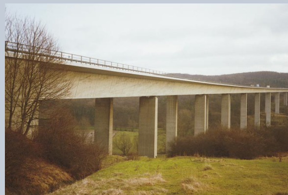
Twistetalbrücke, BAB A44 Kassel – Dortmund, Deutschland
