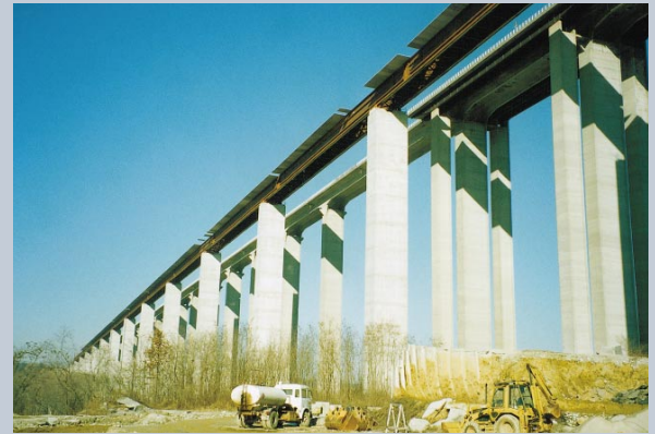
Stura di Demonte Viadukt, Italien
