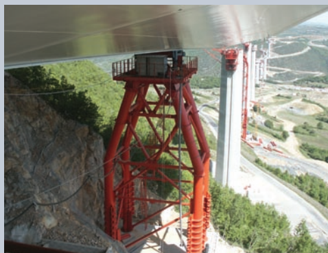
Viadukt Millau/Frankreich: Taktschiebesystem aus 64 synchron gesteuerten MSM®-Vorschubeinrichtungen
