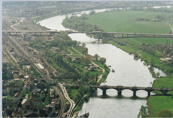
Elbebrücke Pirna, Deutschland
