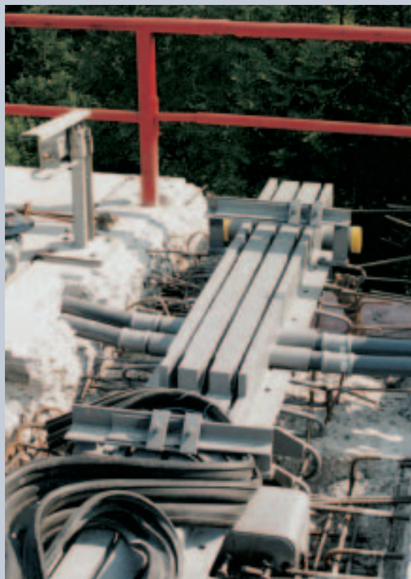
Dehnfugenkonstruktion im Kappenbereich mit Kabelrohrdurchführung
