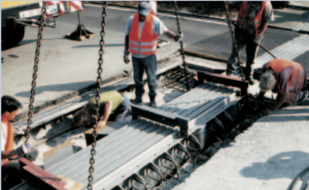
Einlegen der kompletten Dehnfugenkonstruktion in die Bauwerksfuge
