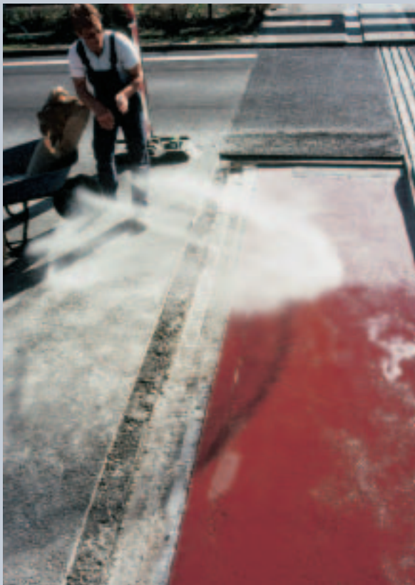
Abstreuen der Abdichtung mit Quarzsand
