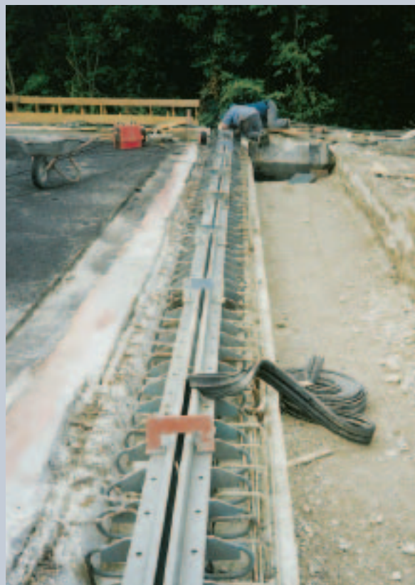
Montage einer Dehnfugenkonstruktion Typ D80
