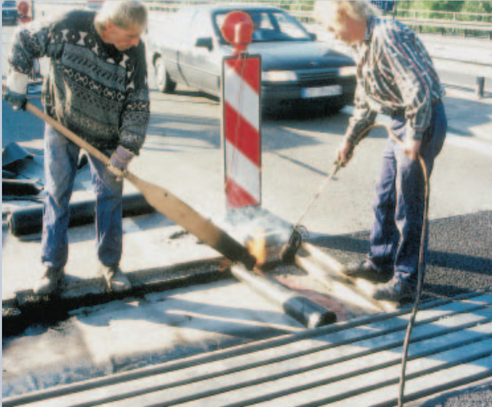
Die Abdichtung wird heiß aufgeklebt
