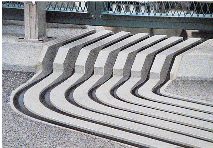
Bild 1: Schwenktraversen-Dehnfugen für komplexe Bauwerksbewegungen
