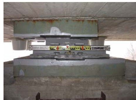
MSM ® -Kalottenlager im eingebauten Zustand
