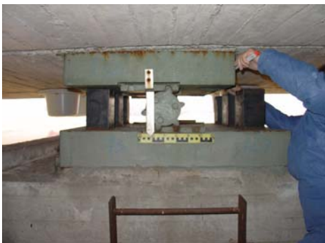
Hochfestes Edelstahlrollenlager mit Notstapeln
