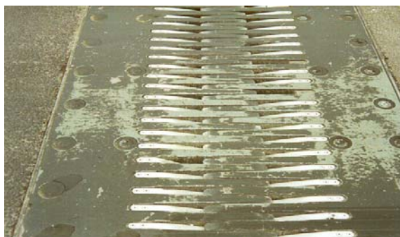
Abb. 4: Angebliche Fahrradsicherung an Fingerfugen
