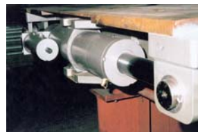
Topflager mit Shock-Transmitter MSTU
