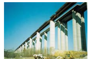
Stura di Demonte Viadukt, Italien
