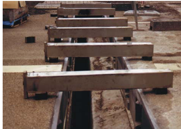
Freigelegte MAURER Schwenktraversen-Dehnfuge mit ausgefädelten Traversen
