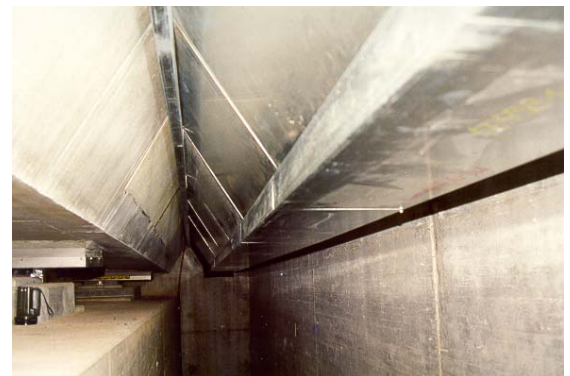
Fertig montierte Dämmkonstruktion (System A)
