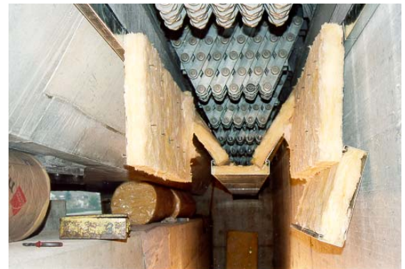
Scherenkonstruktion mit teilweise montiertem Faltsystem
