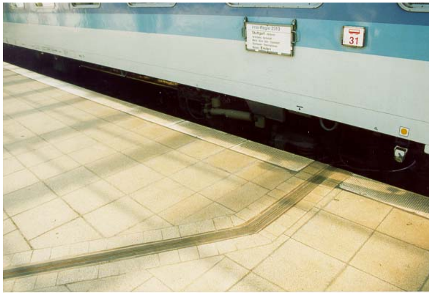
Kompaktfuge K30 N-KD / Hauptbahnhof Köln insgesamt 520 lfm eingebaut bei Bahnsteigsanierung
