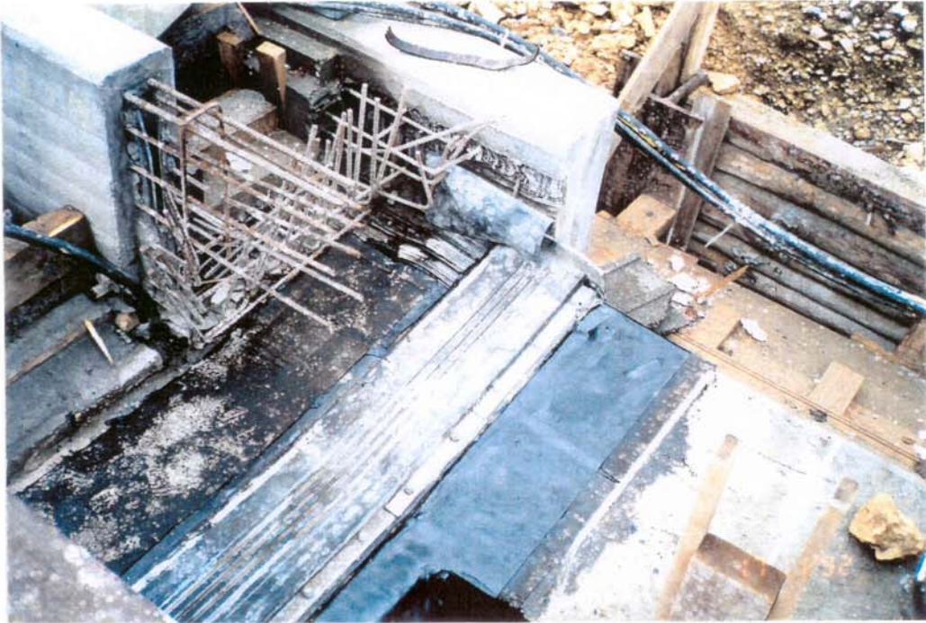
Fertig angeschlossene Abdichtung, überbau- und widerlagerseitig Readily connected sealant, both at superstructure and abutment
