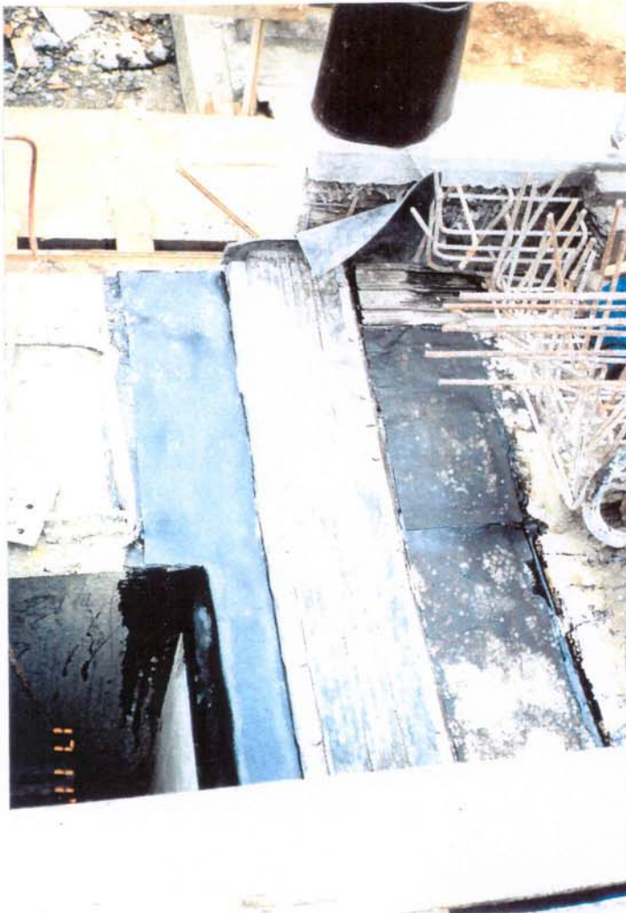
Fertig angeschlossene Abdichtung, überbau- und widerlagerseitig Readily connected sealant, both at superstructure and abutment
