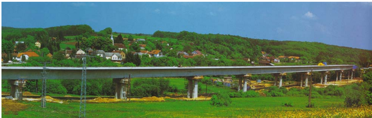
Eisenbahnbrücke Zalalövö-Bajánsénye/Ungarn (1999 – 2000), 82 Topf-Messlager, Auflasten bis 12000 kN
