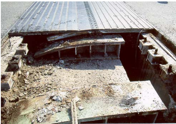
Spurweise Ausbau der Rollverschlußkonstruktionen
