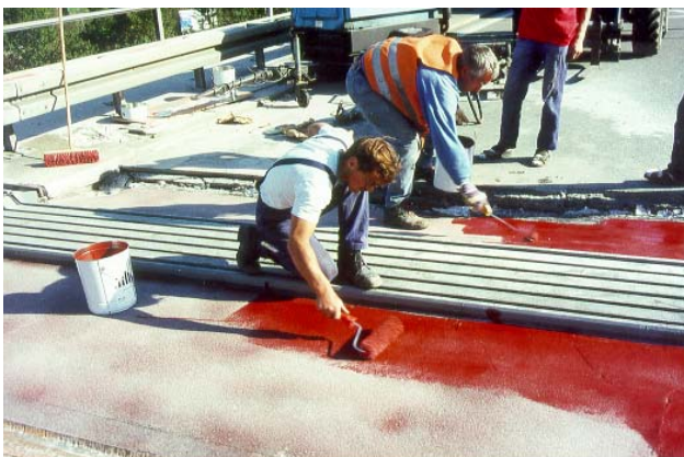
Versiegeln des abgebundenen Betons mit Kunstharz und anschließend Abstreuen mit Quarzsand.
