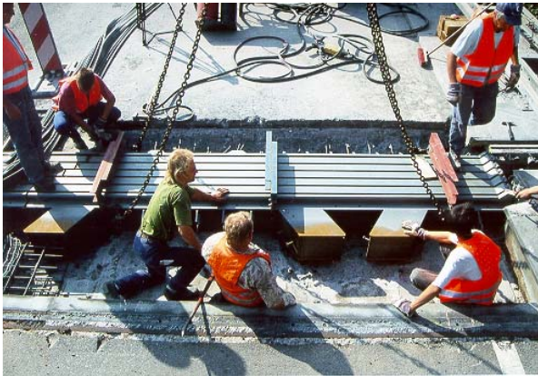
Maßgerechtes Ausrichten der neuen Dehnfugen in der Bauwerksfuge.
