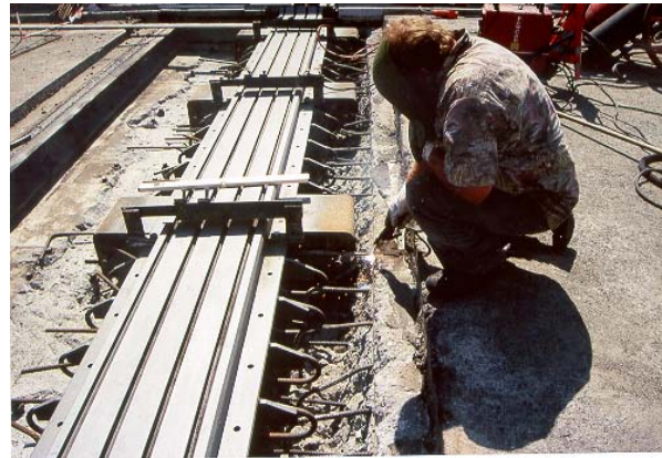
Verschweißen der bauseitigen Bewehrung mit den Verankerungsbügeln.
