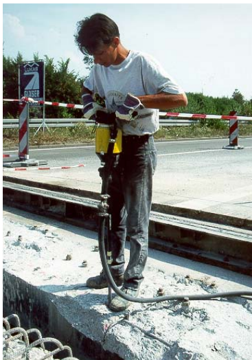
Bohrarbeiten zum Einlegen von zusätzlichen Bewehrungsseisen zur Verankerung der neuen Dehnfugen.
