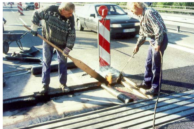
Die Abdichtung wird heiß aufgeklebt.
