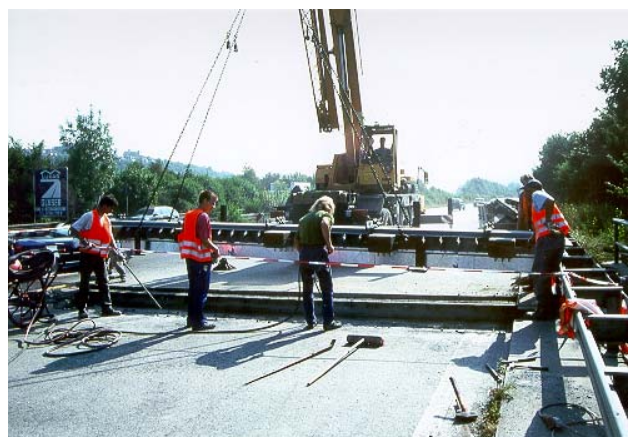
Einlegen der neuen Dehnfugen in die Bauwerksfuge.
