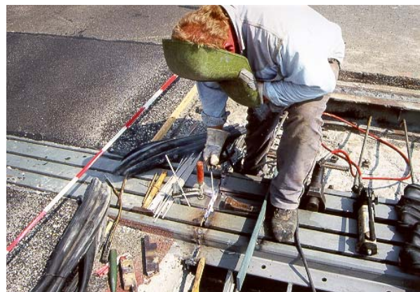
Die Konstruktion wird durch den Schweißstoß in ihrer Lebensdauer nicht beeinträchtigt. Nach dem Schweißen wird die Profilloberfläche verschliffen und der Korrosionsschutz aufgebracht.
