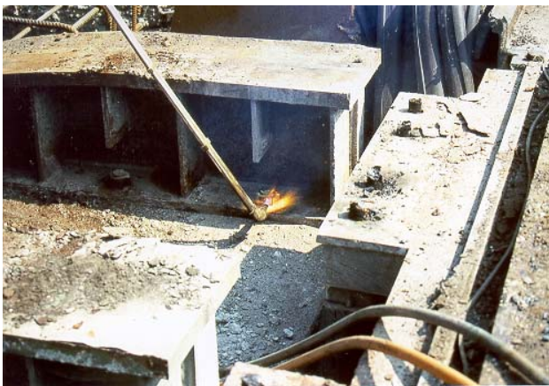
Die Gleitböcke wurden nach dem Abbrennen der zugehörigen Verankerungsschrauben ebenfalls entfernt.
