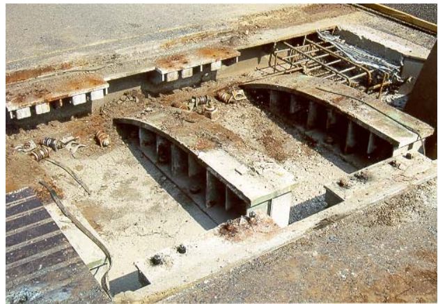
Zuerst wurden die Gleit-, Pendel- und Zungenplatten der alten Rollverschlußkonstruktion ausgebaut. Das Lösen der Verankerungsschrauben war nicht zerstörungsfrei möglich.
