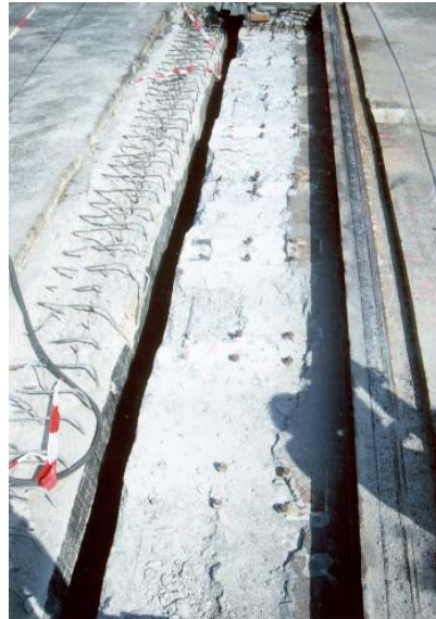
Vorbereiten der Betonaussparungen auf Überbau- und Widerlagerseite zum Einbau der neuen Lamellendehnfugenkonstruktion
