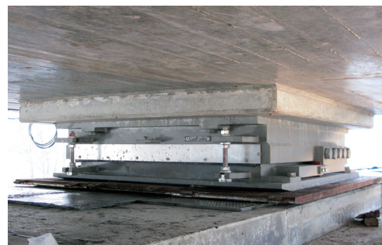
Endposition des MSM-Kalottenlagers nach dem Querverschub. Das Lager ist noch auf dem Verschlager arretiert.
