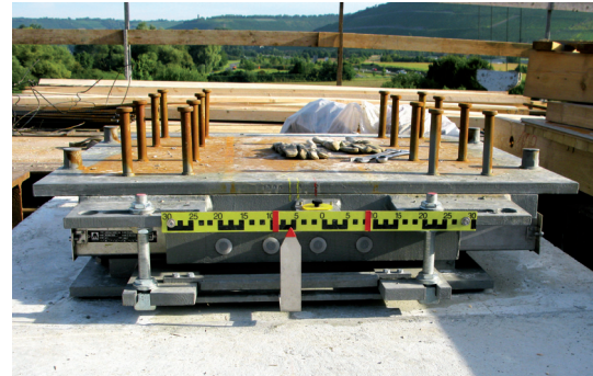
Einbau eines MSM-Kalottenlagers auf einem Pfeilerkopf. Der Brückenüberbau folgte später im Freivorbau. Vorne erkennbar die Arretiervorrichtungen.
