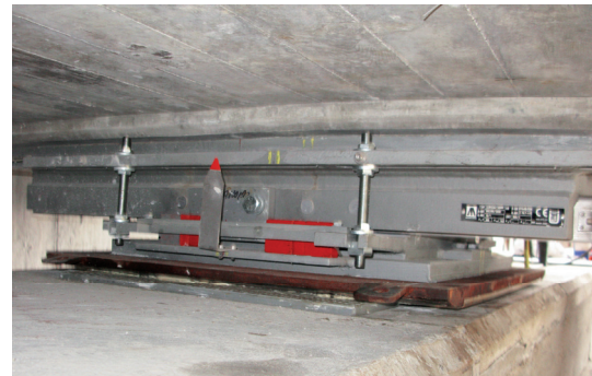
Arretiertes MSM-Kalottenlager am Widerlager (Achse 100) vor dem Querverschub.
