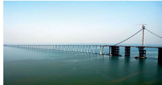
Qingdao-Haiwan-Brücke im Bereich der Hängebrücke, an der Fahrbahnübergänge mit Dehnwegen bis zu 1120 mm eingebaut wurden.
