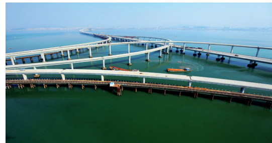
Die Qingdao-Haiwan-Brücke verbindet die Stadt Qingdao mit Huangdao und dem Flughafen Qingdao-Liuting.
