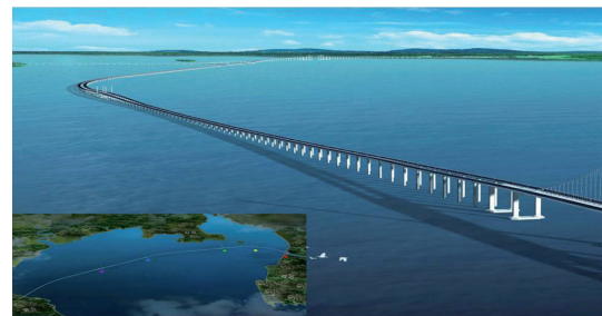
Die Qingdao-Haiwan-Brücke in Planung, links unten mit Lageplan, vorne die Hängebrücke für die Schiffsdurchfahrt, links im Hintergrund die Brückenkreuzung.
