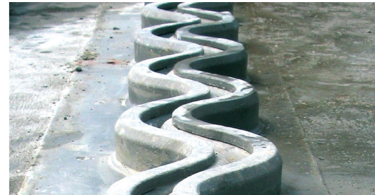
Bauphase: Im Beton eingebaute und verankerte XW-1-Fuge.
