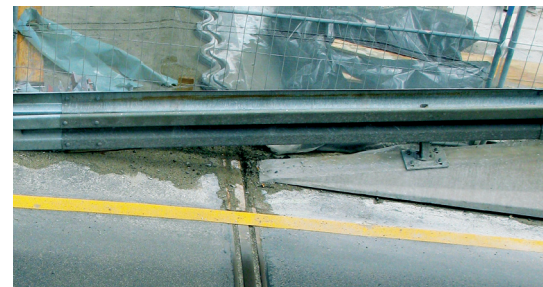
Alt und neu: Vorne die alte mehrprofilige Dehnfuge, hinter der Absperrung die neue Wellen-Dehnfuge.
