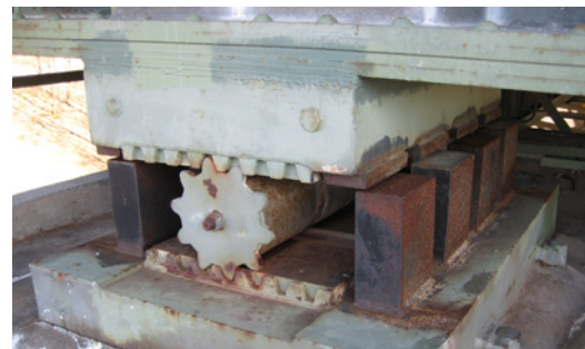
Vorher: Ein altes Rollenlager vor dem Ausbau.
