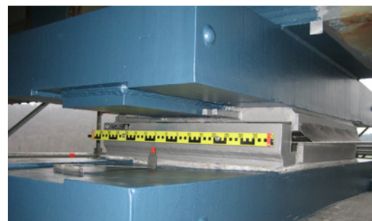
Nacher: Eines der ersten eingebauten Doppelzylinderlager an der Grenzwaldbücke (A7).
