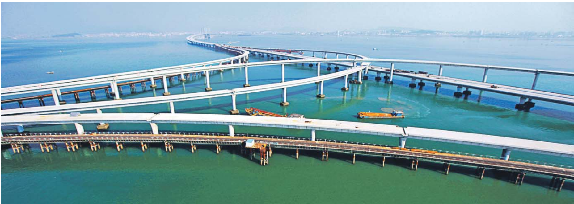
Tausendfüßler: Rund 200 Dehnungsfugen schlucken in der Qingdao-Haiwan-Brücke die temperaturbedingten Längenänderungen.
