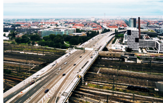
Die Donnersberger Brücke in München, an deren Auf- und Abfahrtsrampen weltweit erstmalig die MAURER-XW1 Wellendehnfugen eingebaut wurden.
