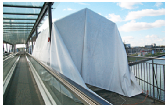
Der Einbau der Dämpfer musste aus optischen Gründen unter einem Zelt erfolgen.
