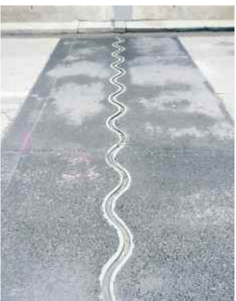
Großbaustelle Donnersbergerbrücke: Seit Monaten wird das Bauwerk saniert, die Fahrbahnen müssen immer wieder verengt werden. In den Belag sind neuartige Fugen eingebaut worden – sie sollen den Lärm mindern. Fotos: Maurer Söhne/oh
